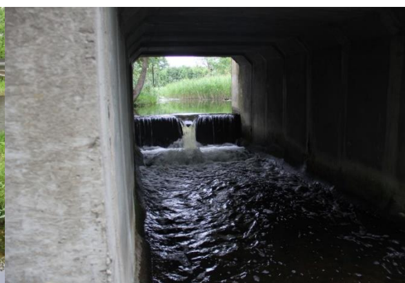
3.2.3. attēls. Jašas upes Kastīres ciemā ir izbūvēts aizsprosts – regulators. Skats no Jašas upes puses (Foto: M. Nitcis)
